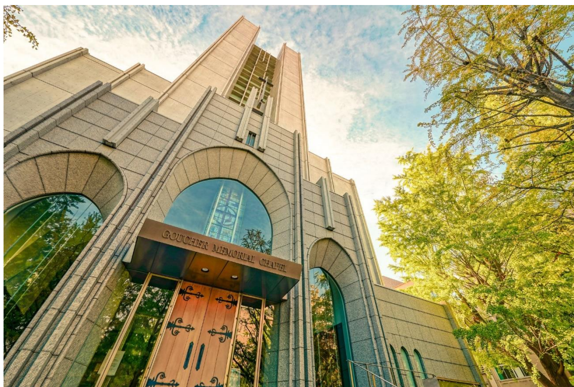
15号館（ガウチャー・メモリアル・ホール）
