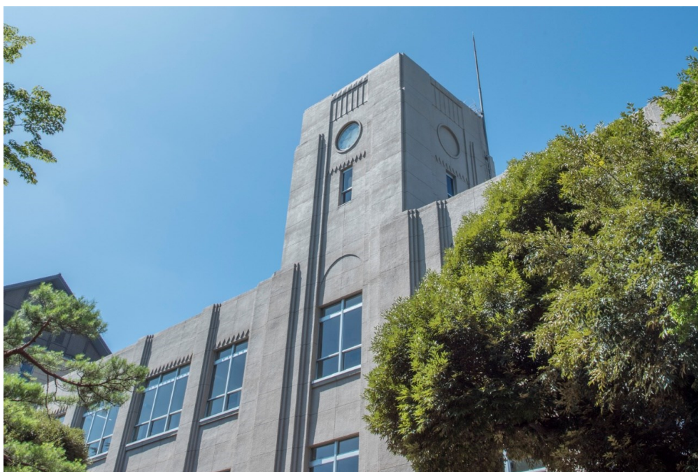
3号館。1923年建築の、都内でも珍しい関東大震災を耐え抜いた建物。
