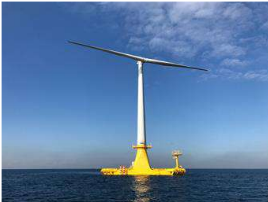
図 北九州市沖へ設置した次世代浮体式洋上風力発電システム実証機
