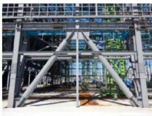
ブレース型制振ダンパーの取付状況と詳細（本開発）
