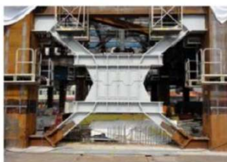
ブレース型制振ダンパーの取付状況と詳細（本開発）
