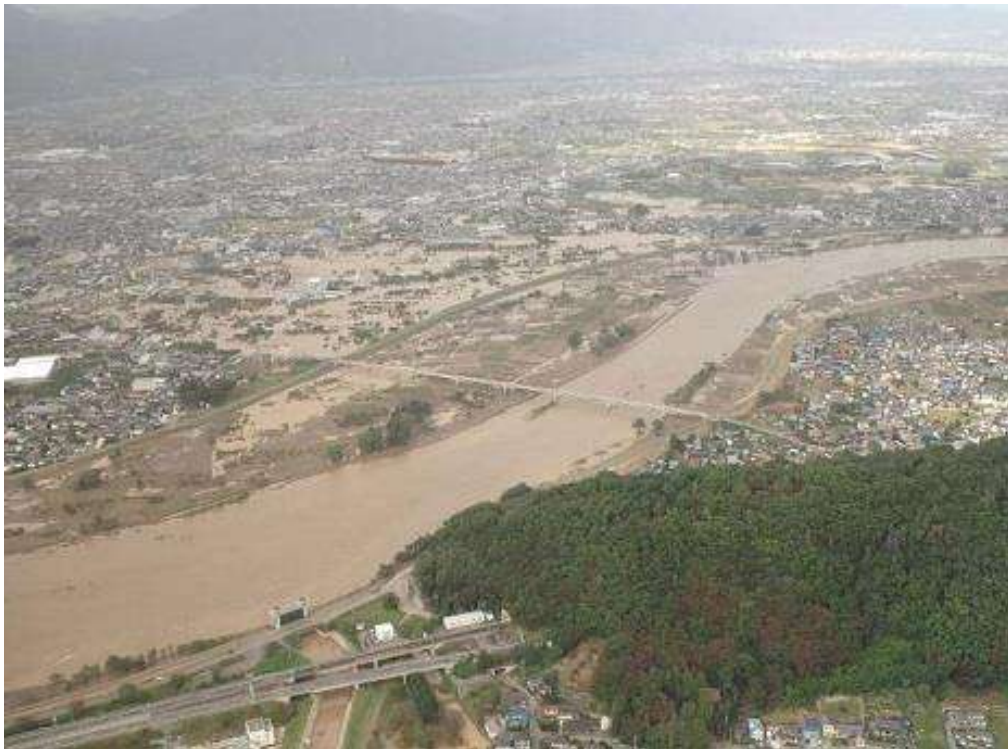
内閣府が公開した被災現場写真3（千曲市）
